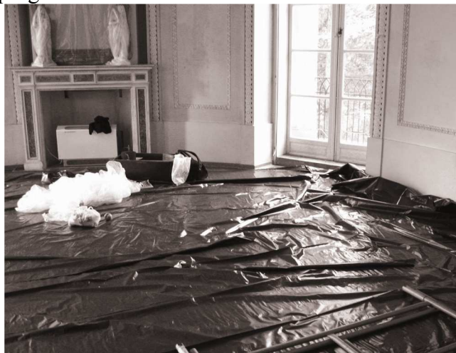
Fot. Remont stolarki okiennej
