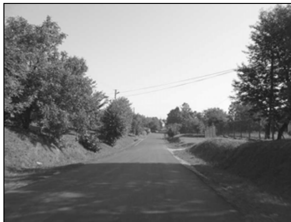
Nowa nawierzchnia drogi powiatowej - Siennów
