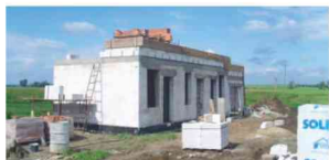
Budowa zaplecza sportowego przy boisku w Maćkówce
