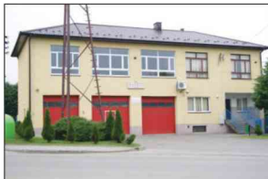
Nowe pokrycie dachowe remizy OSP w Zarzeczcu
