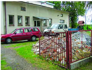
Budynek Środowiskowego Domu Samopomocy w Zalesiu
