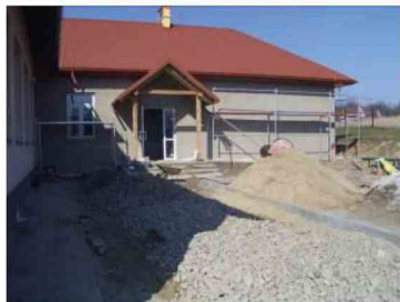
Roboty zewnętrzne przy rozbudowywanej szkole
