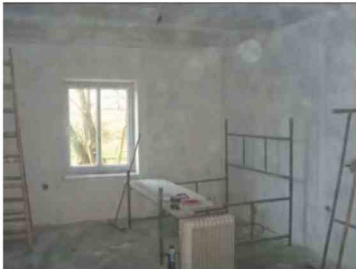
Remont oficyny dworskiej w Siennowie
