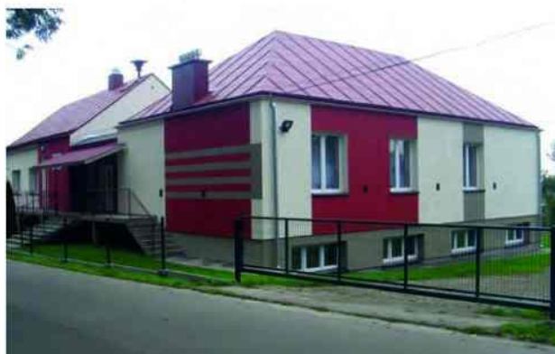
Remiza OSP po modernizacji
