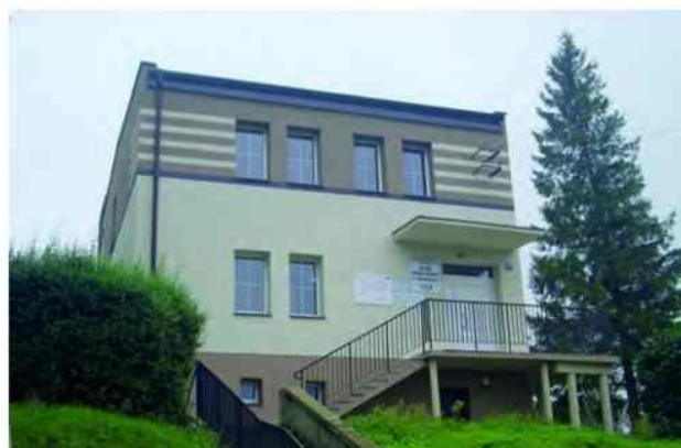
Zmodernizowany budynek Ośrodka Zdrowia
