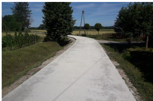
Budowa drogi w Pełnatyczach
