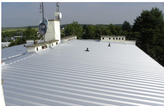
Nowy dach na Ośrodku Zdrowia w Zarzeczu
